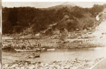
年間約100日位を労力奉仕に費して築港に尽力したという村民の作業ぶり
